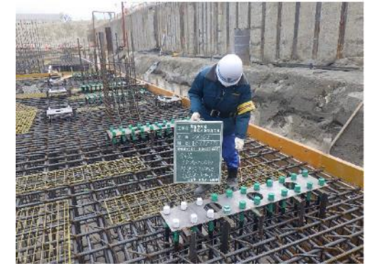
アンカーボルトの埋め込み
