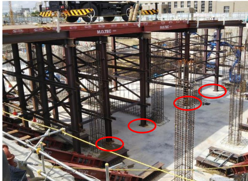
底版上への仮栈橋の設置
