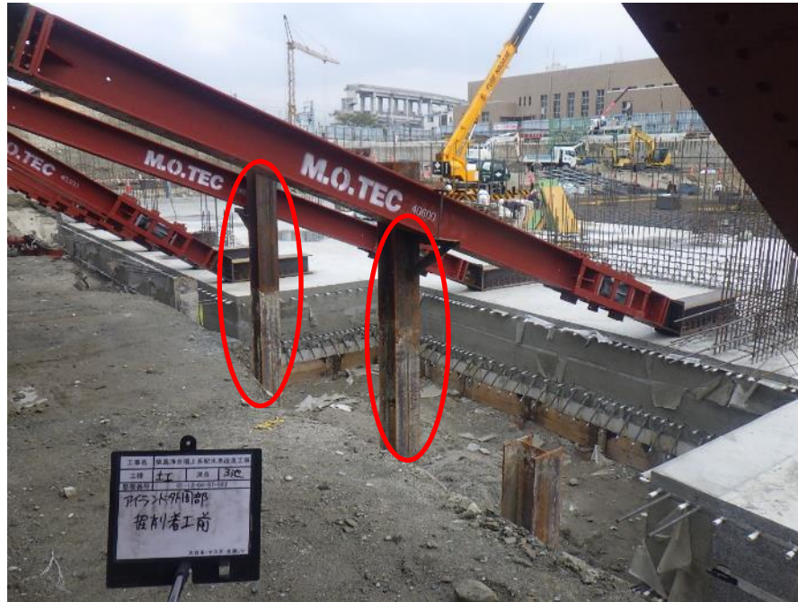
長い斜梁への棚杭の設置
