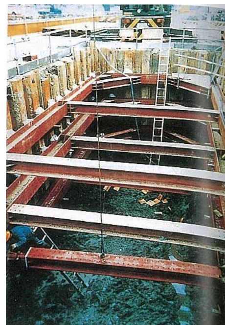
図2 切梁の設置作業状況 2)
