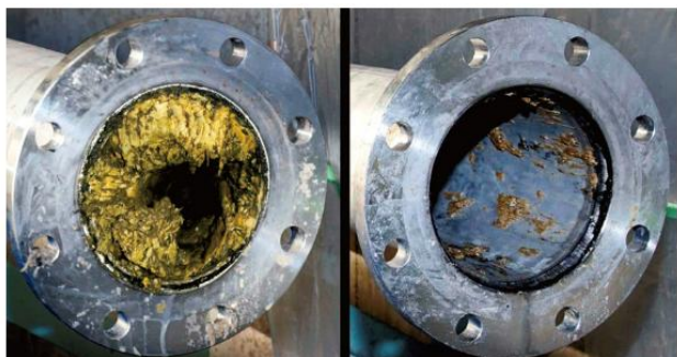
左：洗浄前 右：洗浄後 濃縮汚泥配管の洗浄例
